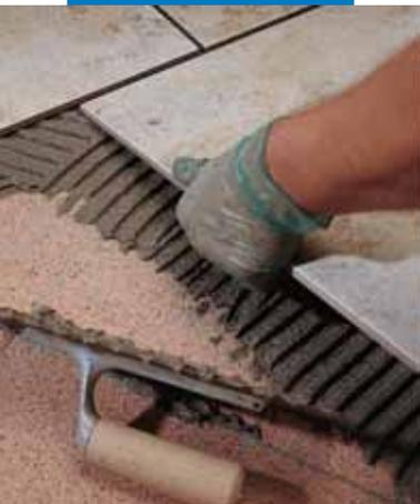
Нанесение покрытия из плитки одинарного обжига поверх плитки из каменной крошки
