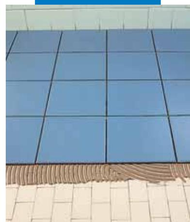
Укладка плитки с помощью серого клея **Keraflex** поверх имеющейся плитки
