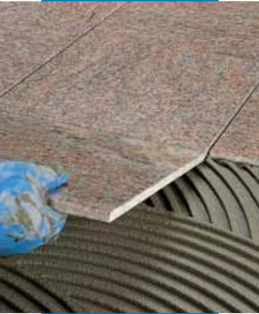
Укладка полированного мрамора в качестве полового покрытия
